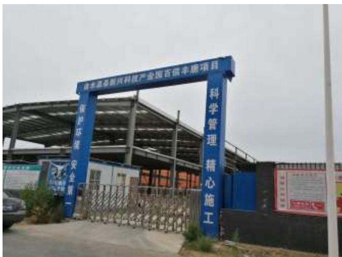
项目南侧（尚未建成）
