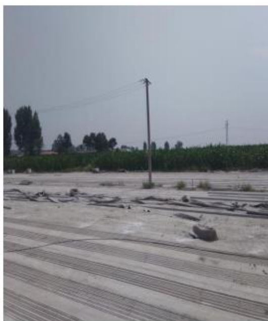
项目厂区东侧
